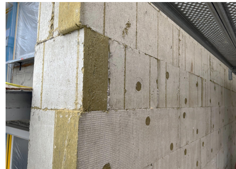
© Ingenieurbüro Kaucher GmbH
