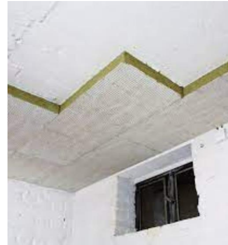
© Ingenieurbüro Kaucher GmbH
