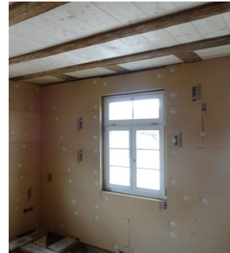
© Ingenieurbüro Kaucher GmbH
