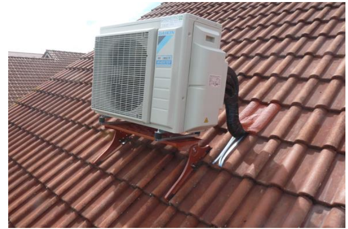
© Ingenieurbüro Kaucher GmbH
