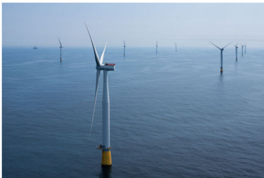
Die Offshore-Windkraftanlagen von Hywind Tampen sind auf einzelnen Betonschwimmern montiert und nicht einzeln am Meeresboden verankert. (Bild: Ole Jørgen Bratland / Equinor)
